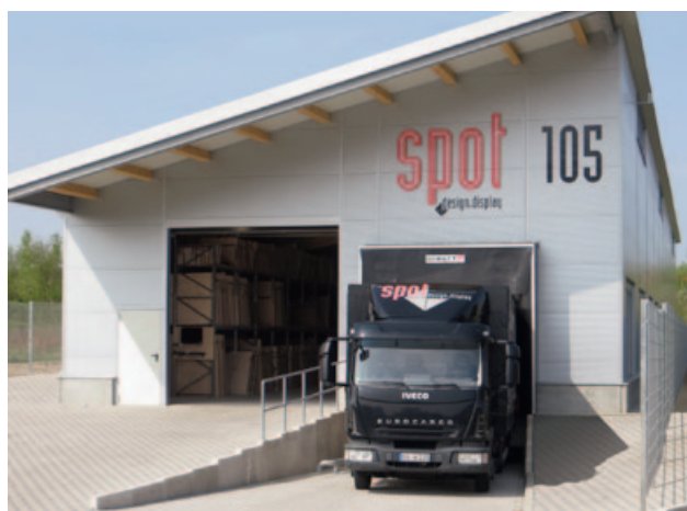
Neubau der Fa. spot an der Wasserwerkstraße
