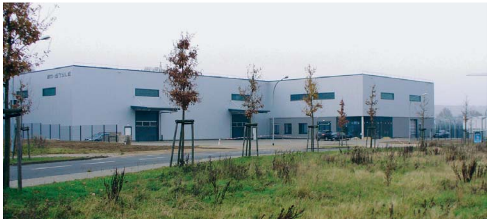
Neubau der Firma M-Style im Gewerbegebiet „An der A 33“
