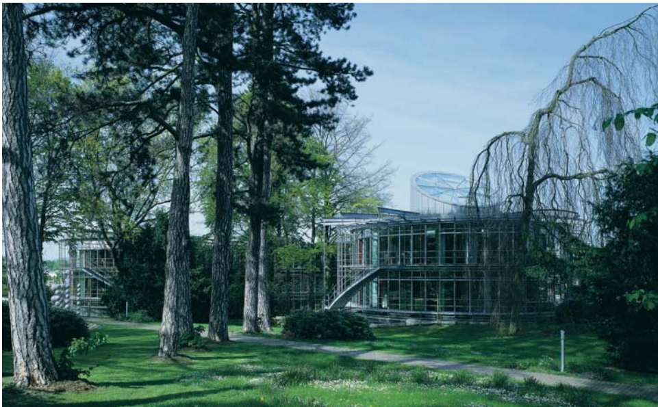
Zentrale für den innovativen Umweltschutz in Deutschland: Die Geschäftsstelle der Deutschen Bundesstiftung Umwelt (DBU) in Osnabrück
