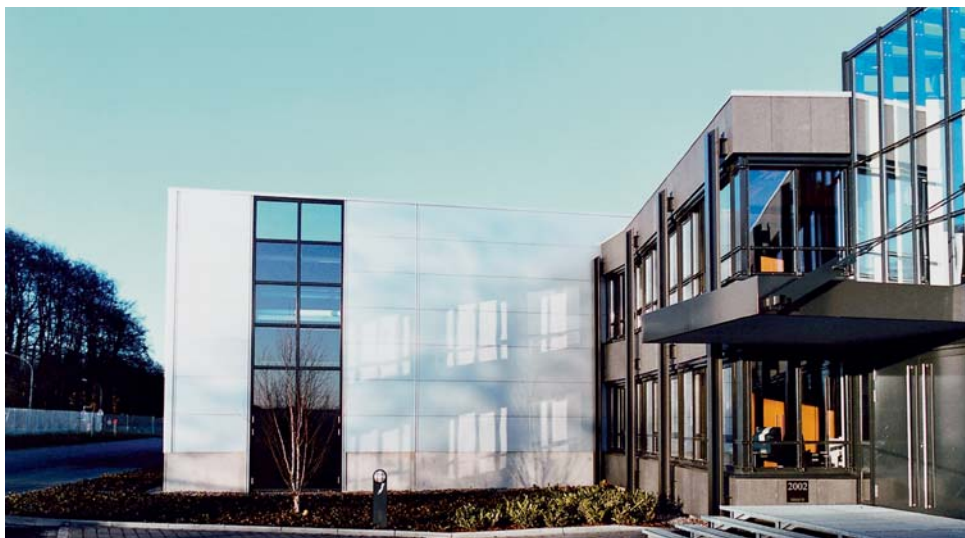
Gewerbehalle der Fa. Symanzik / Thermodyne im Gewerbegebiet Am Tie
