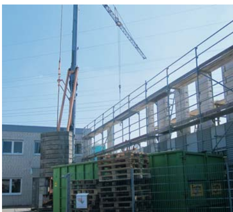
Die neue Produktionshalle entsteht auf dem Firmengelände der spot GmbH in Osnabrück Voxtrup
