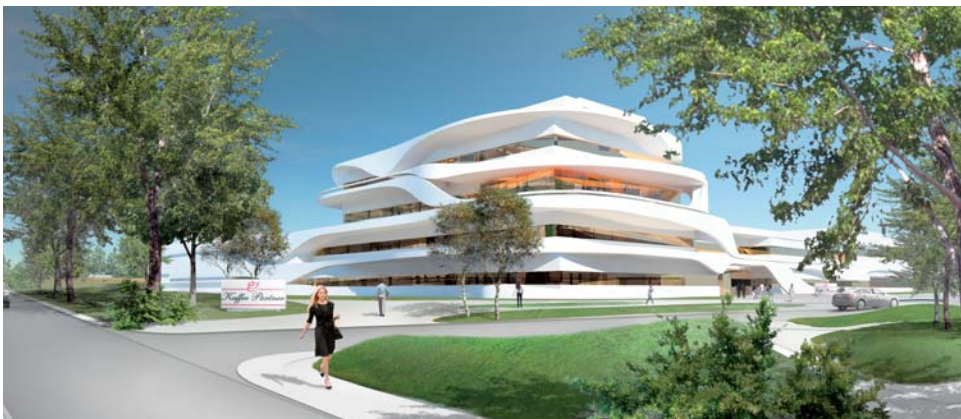
Ansicht von der Römereschstraße auf das vom Architektenteam 3deluxe aus Wiesbaden entworfene Gebäude. Die igk Krabbe aus Osnabrück ist federführend für die Umsetzung der Pläne verantwortlich.
