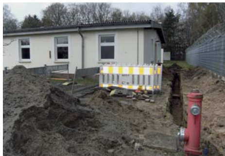
Die ersten Bauarbeiten haben bereits begonnen
