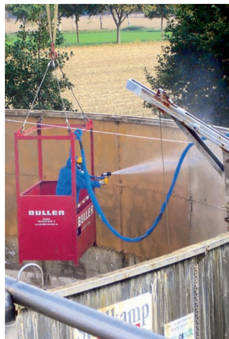
Meyer Entsorgung setzt innovative Beschichtungsverfahren für Abwasserbauwerke ein
