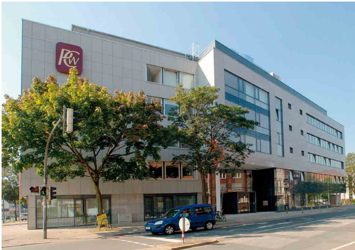
Erweiterungsbau PricewaterhouseCoopers AG (Quelle: Löffler Immobilien)
