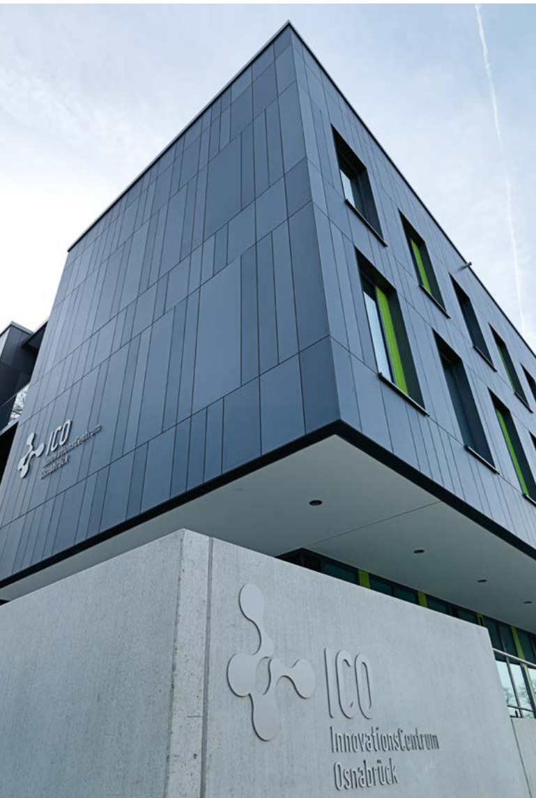
Das fertiggestellte InnovationsCenter im WissenschaftsPark, Quelle: ICO GmbH
