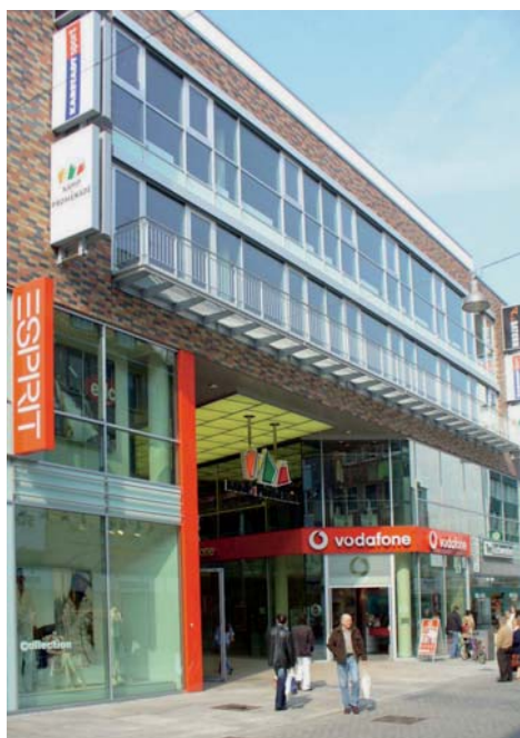
Die neuen Büroräume von Imtech in der Kamp-Promenade
